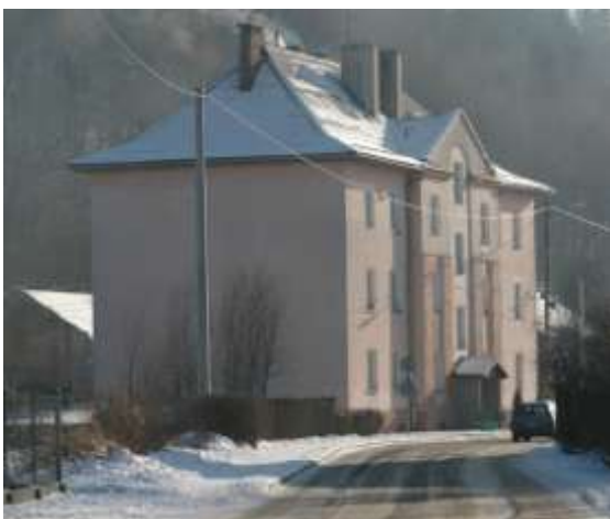
fot. 1 Blok wybudowany dla pracowników fabryki celulozy
